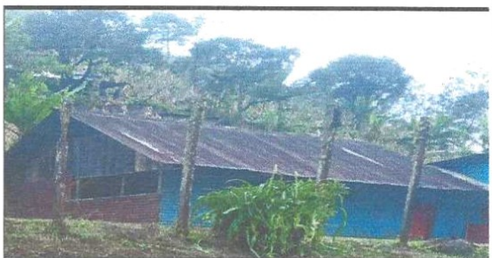
foto 6. Sustitución de lamina en mal estado.
