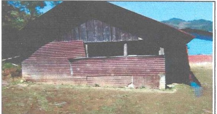
foto 4. Rehabilitación y mantenimiento de paredes.
