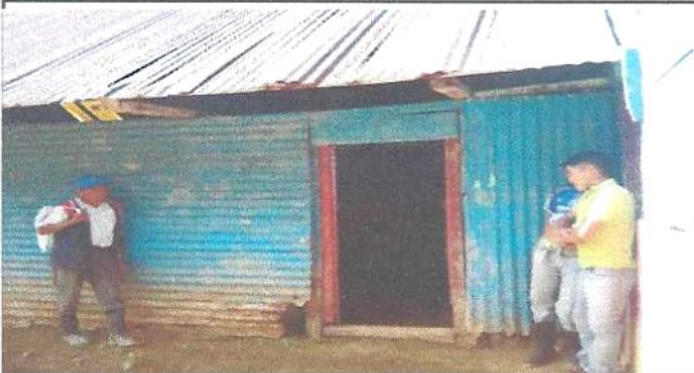
foto 3. Sustitución de puerta.
